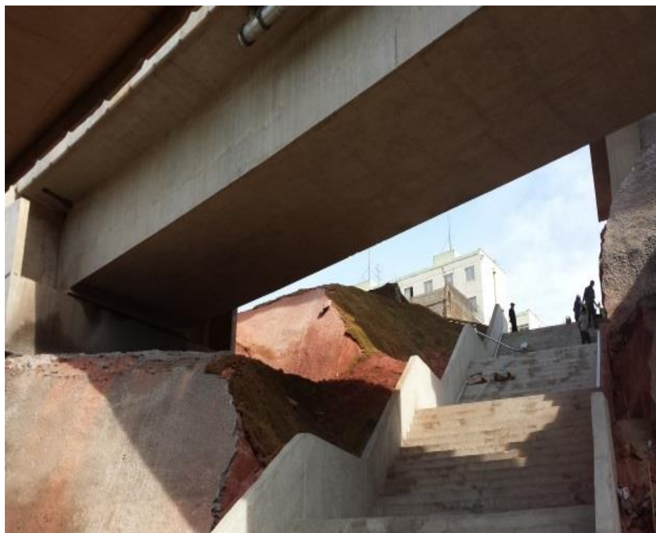
Figura 2 - As obras de acesso
