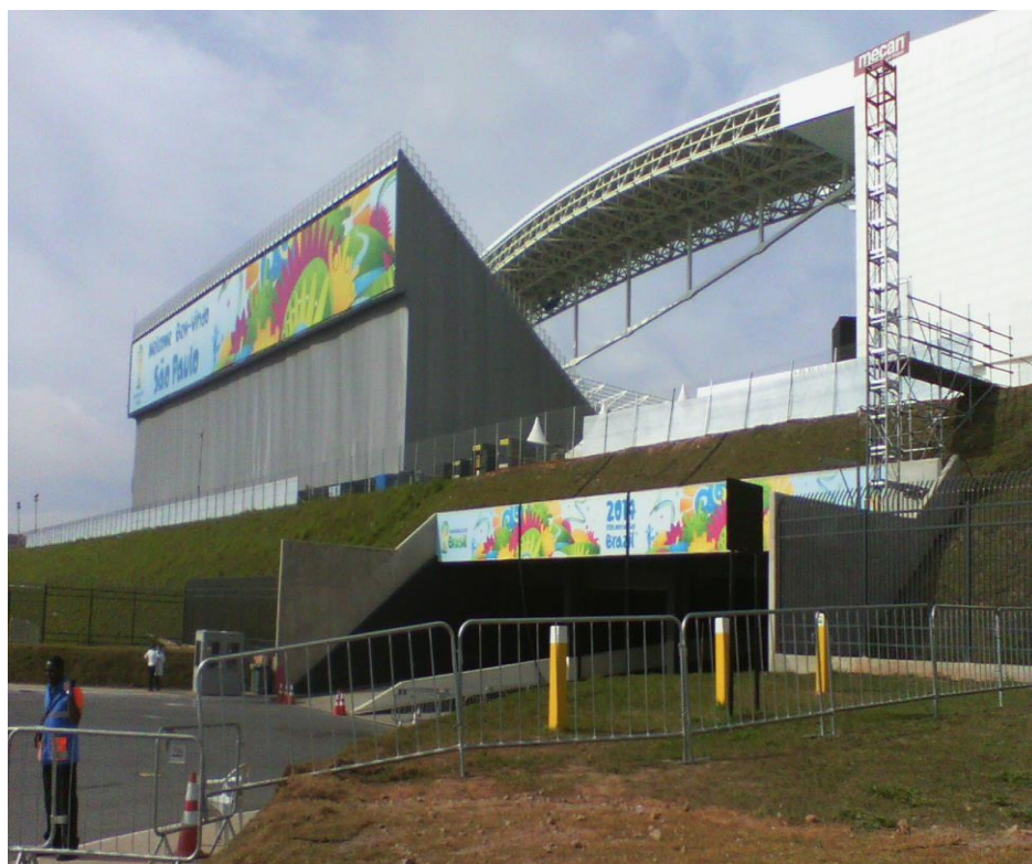
Figura 3 - Entrada oeste do Itaquerão – “Arena Corinthians”, ainda inacabado
