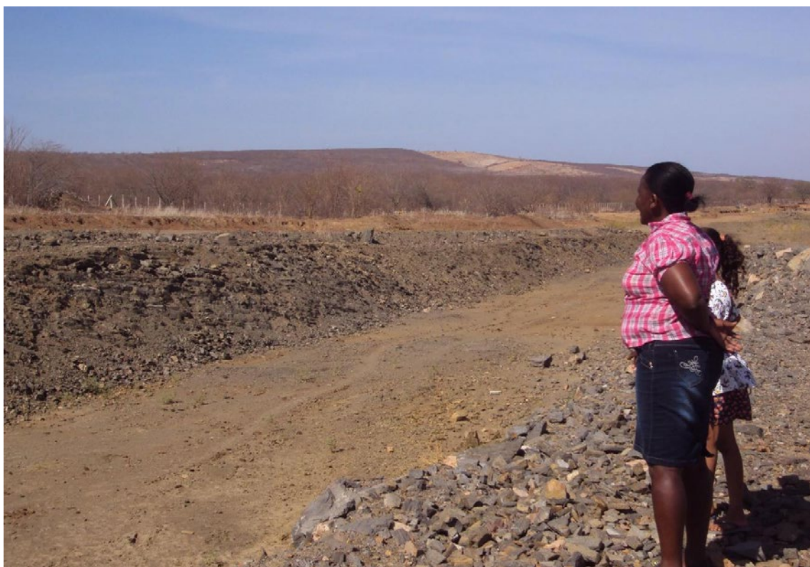
Imagem 8 - Moradora da comunidade de Contente – PI, observa um trecho das obras a 300 metros de sua casa Autoria: George Michael Alves de Lima, 2013
