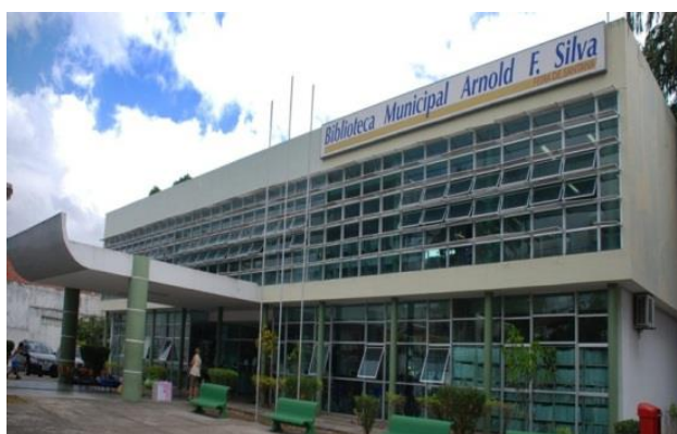
Figura 2 - Biblioteca Municipal de Feira de Santana – Atualmente
