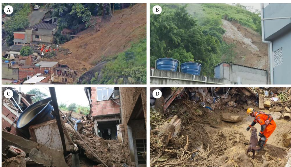
Figura 1 – Deslizamentos de terra em São Gonçalo em 2023
