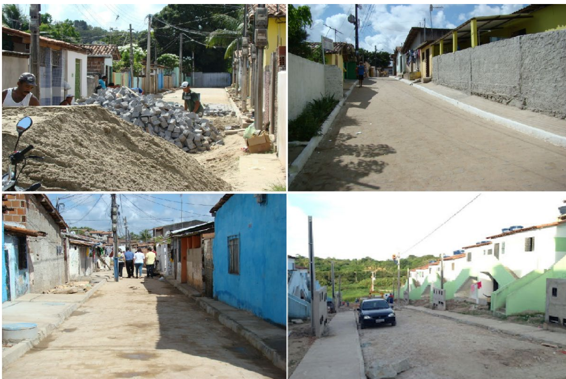
Figura 03 – Compilado de imagens do Timbó, veiculadas no blog, com as obras de urbanização
