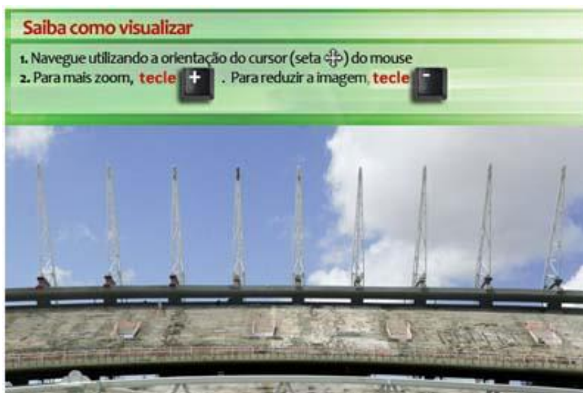
Figura 4 - Infográfico da reportagem “Fase 3 do Castelão já está 80% concluída”
