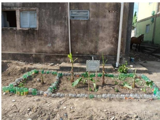
**Figura 17.** Plantio das mudas sobre o Tanque de Evapotranspiração no condomínio Amizade, Paratibe, João Pessoa, PB.
