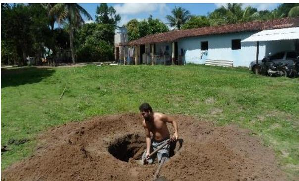
**Figura 3.** Escavação do círculo de bananeiras em Engenho Velho, para o tratamento das águas cinzas domiciliares.
