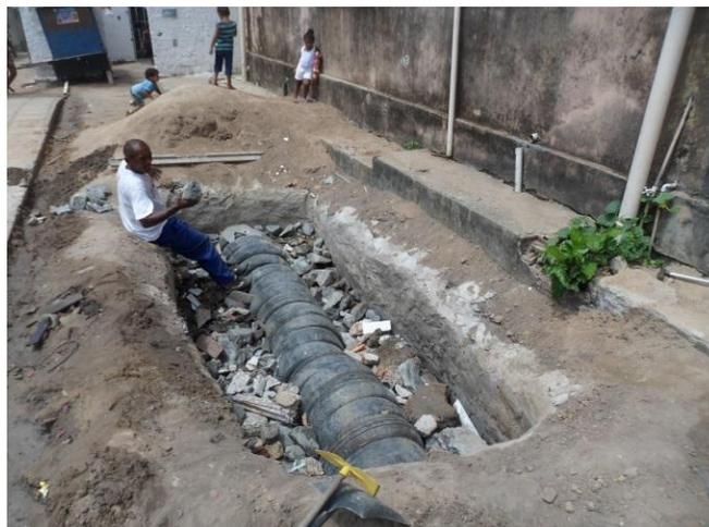
**Figura 14.** Preenchimento do tanque de evapotranspiração com metralha, no condomínio Amizade, Paratibe, João Pessoa, PB.
