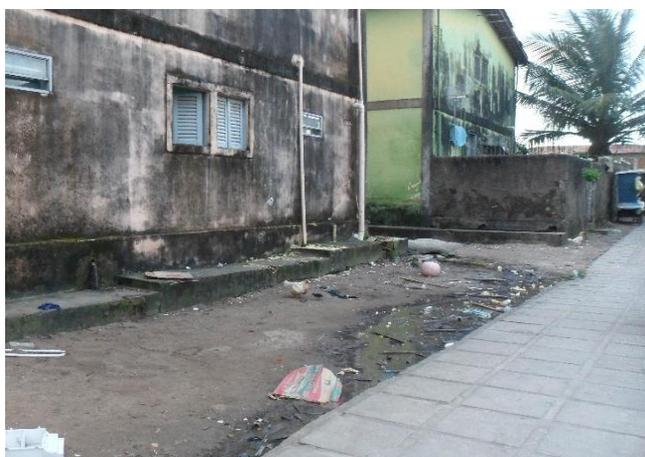
**Figura 9.** Efluente de esgoto vazando entre os prédios do condomínio Amizade, Paratibe, João Pessoa, PB.
