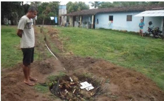
**Figura 5.** Colocação do encanamento das águas cinzas da casa para o círculo de bananeiras, em residência de Engenho Velho, Paraíba.
