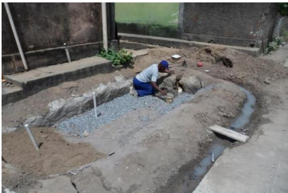
**Figura 15.** Preenchimento das camadas do tanque de evapotranspiração com brita, areia e solo, após a metralha, no condomínio Amizade, Paratibe, João Pessoa, PB.
