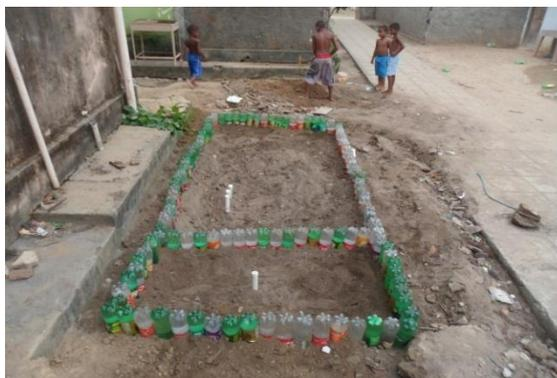
**Figura 16.** Construção de um rebordo no tanque de evapotranspiração, com garrafas pet, para impedir a entrada de águas pluviais, no condomínio Amizade, Paratibe, João Pessoa, PB.
