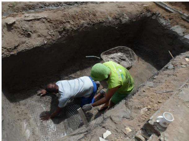
**Figura 12.** Impermeabilização do tanque de evapotranspiração com tela e cimento, no condomínio Amizade, Paratibe, João Pessoa, PB.
