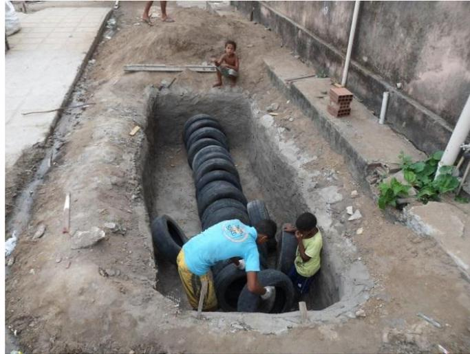
**Figura 13.** Colocação de pneus para fazer a câmara que receberá o esgoto bruto de residências no condomínio Amizade, Paratibe, João Pessoa, PB.
