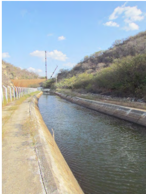
Figura 1. Início do Canal da Redenção às margens da Barragem Mãe D'Água
