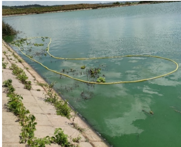
Figura 1 - Implantação das estruturas com macrófitas na ETE de Mamanguape.
