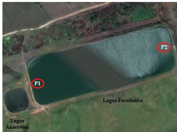
Figura 3 - Vista aérea da ETE-Mamanguape, com localização dos pontos amostrais.
