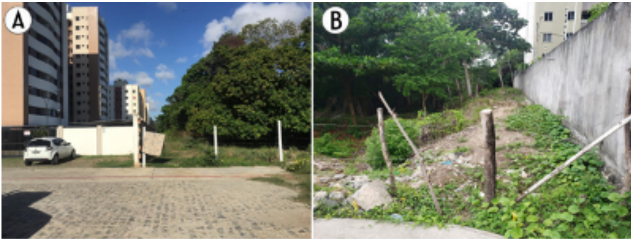
Figura 10. Condomínios situados em APP na Unidade de Paisagem 1.
