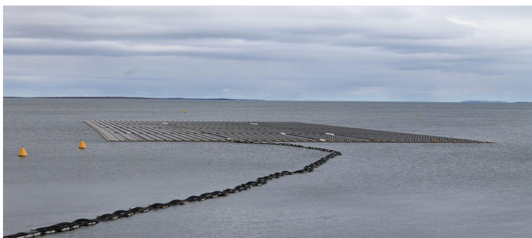
Figura 3. Projeto piloto de usina solar fotovoltaica flutuante no reservatório da usina hidrelétrica de Sobradinho
