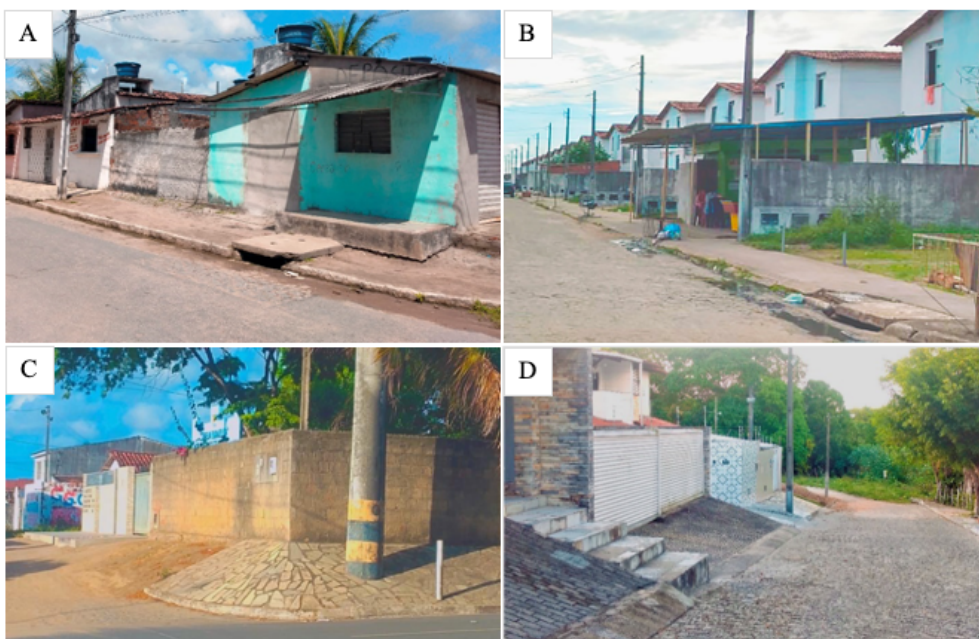
Figura 9. Barreiras à acessibilidade mais comuns nas calçadas, Gramame (João Pessoa, PB). (A) Tampa de inspeção de infraestrutura/ piso inadequado; (B) Estrutura de coberta com apoios na calçada; (C) Inclinação fora da norma/ material inadequado; (D) Rampa e degraus fora da norma.
