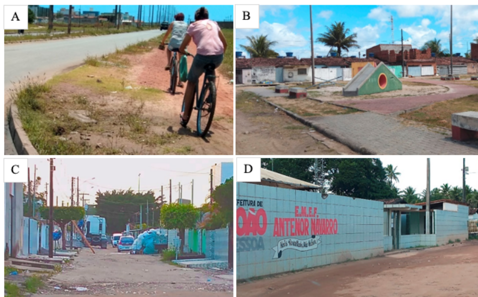
Figura 8. Configurações deficitárias de pavimentação mais comuns nas calçadas, Gramame (João Pessoa, PB): (A) Com meio-fio e sem pavimentação; (B) Com meio-fio e pavimentação danificada/ incompleta; (C) Sem meio-fio e com pavimentação; (D) Sem meio-fio e sem pavimentação.
