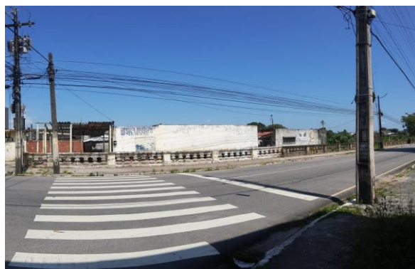
Figura 12 – Imóveis irregulares adjacentes à balaustrada. Fonte: os autores (2023)
