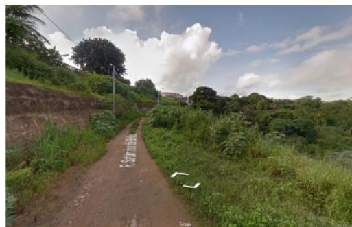
Figura 11 - Comunidade após as obras. Fonte: Google Maps (2023).
