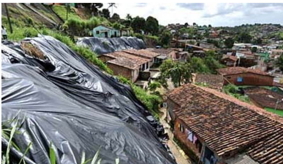
Figura 4. Lonas plásticas usadas como medida paliativa para redução de desabamentos, durante Operação Inverno 2013 iii
