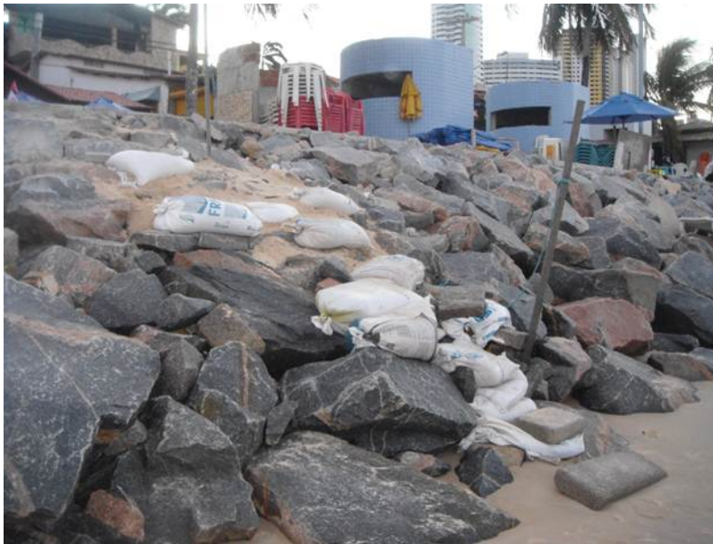
Figura 14: Acesso improvisado no enrocamento. Foto: Rafael Victor Silva (Set/2014)
