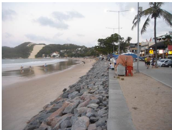
Figura 13: Obra de enrocamento da Praia. Foto: Rafael Victor Silva (Set/2014)
