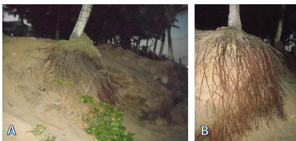
Figura 11: Erosão – Raiz exposta. Foto: Rafael Victor Silva (Set/2014)
