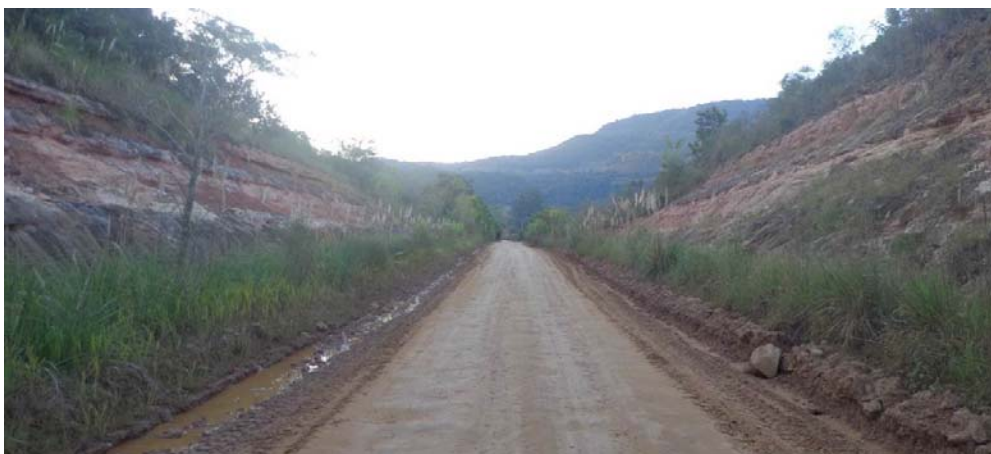
Figura 5 – Visão geral do geossítio Linha da Gruta, às margens da RS 348.
