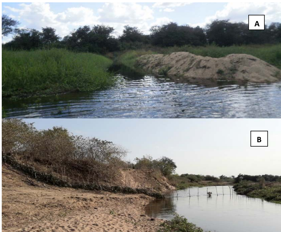
Figura 11: Imagem (A), barramentos construídos sobre o leito do rio Acaraú entre Cariré e Groaíras. Imagem (B), Comunidade de Anil/ Cariré, ausência de mata ciliar, curso d'água descaracterizado e presença de cercas no canal fluvial. Foto: Queiroz, E. R.
