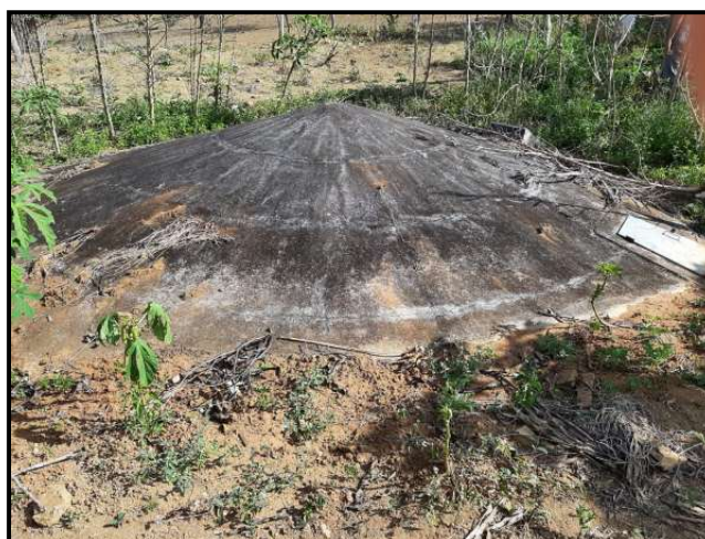
Figura 2. Cisterna de placa de enxurrada no povoado Rio Vermelho.
