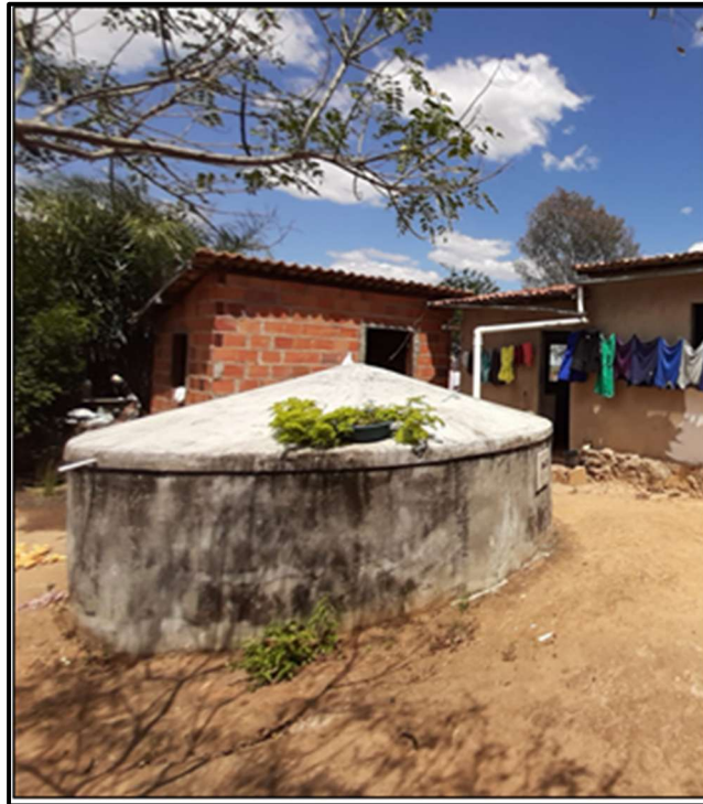
Figura 1. Cisterna de placa de consumo – Povoado Fazenda da Mata.
