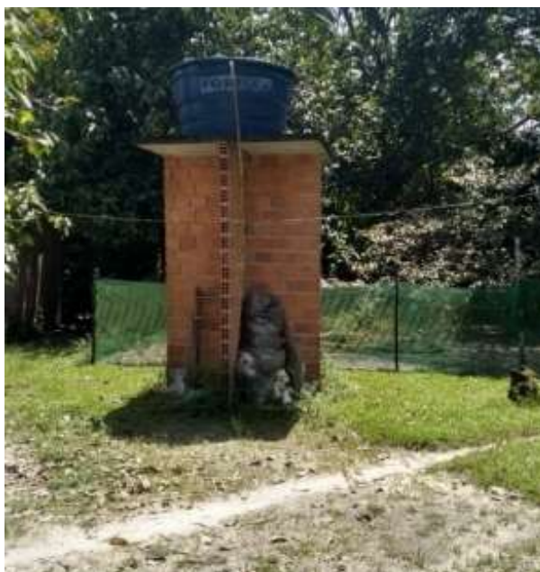
Figura 4. Reservatório (residencial) elevado de água captada do poço comunitário. Fonte: Machado, 2022.
