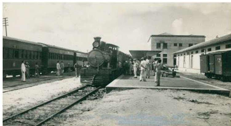
Figura 6. Trem a vapor na antiga estação de João Pessoa Fonte: Lacet, 2017.
