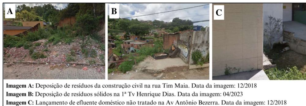
Figura 2 – Registros de fatores que potencializam o risco a movimentos de massa no bairro Curado, Jaboatão dos Guararapes
