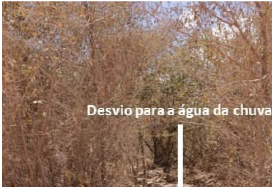
Figura 6 (a, b) – Drenagem para as águas pluviais no topo e sopé do Pontal da Santa Cruz
