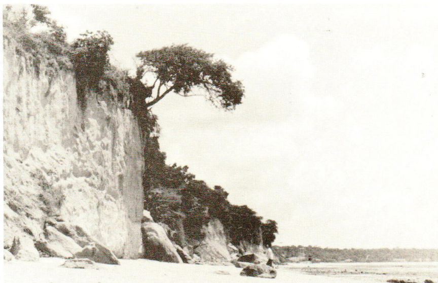
Outro aspecto da falésia do Cabo Branco bastante erodida, vendo-se algumas árvores tentando sustentar-se na maior altura da mesma.
