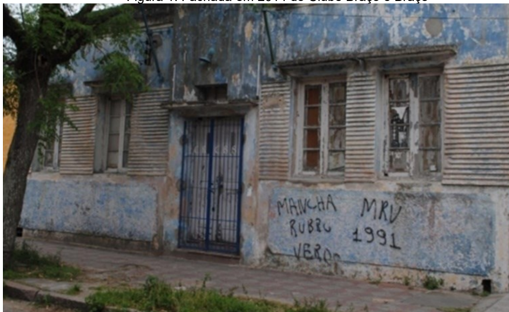
Figura 1. Fachada em 2014 do Clube Braço é Braço
