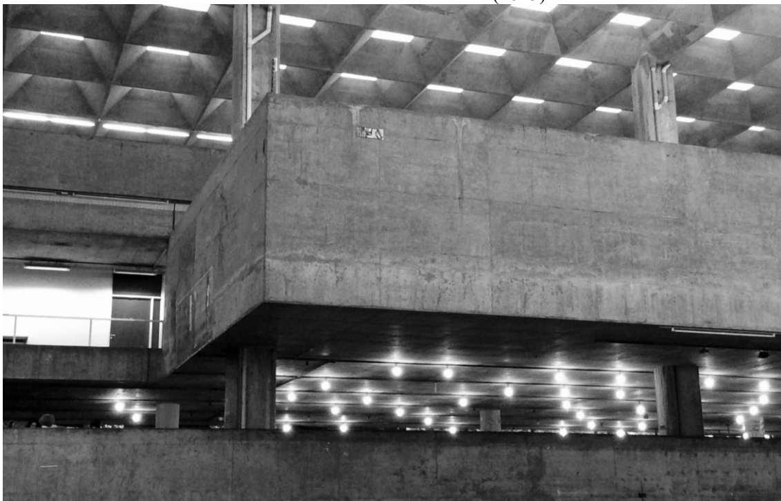
Figura 3 - Faculdade de Arquitetura e Urbanismo e de Design da Universidade de São Paulo (2015)
