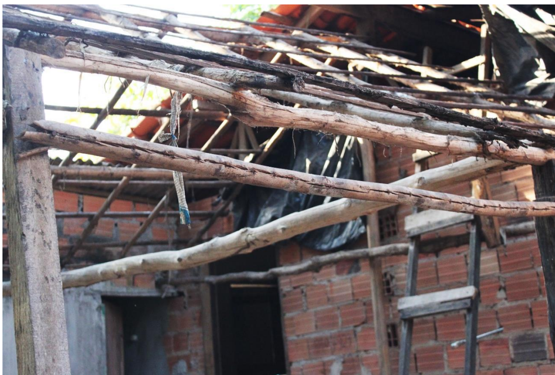
Foto 8: Estrutura parcial de uma casa feita com caules de árvores da região (2016).
