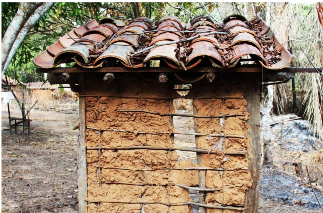
Foto 7: Sanitário tipo “retrete” (2016).
