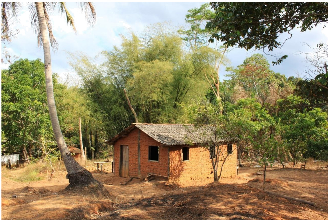
Foto 1: Casa de enchimento (barro) em um dos terrenos na comunidade remanescente quilombola (2016).
