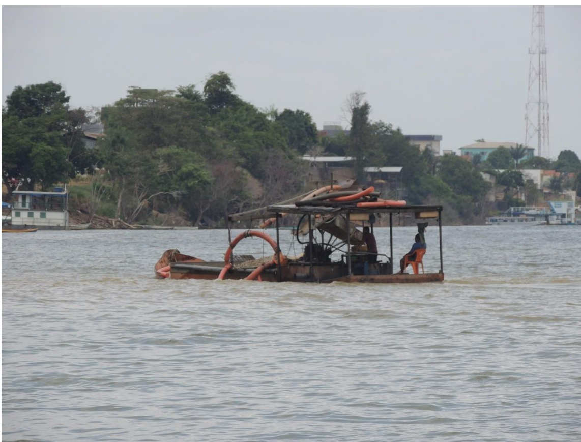
Aporte na margem para descarregamento de areia.
