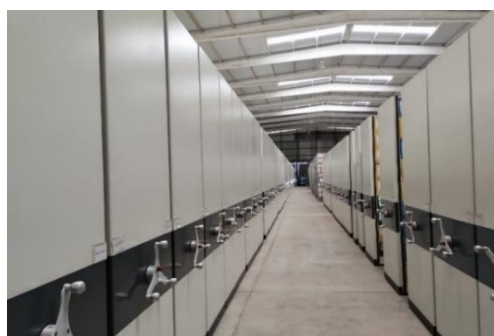
Figura 3 – Estantes de aço deslizantes
