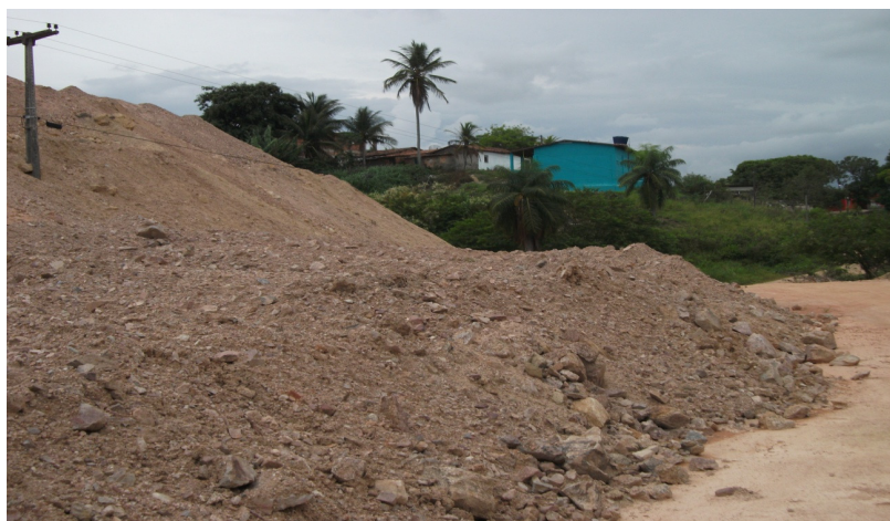
Área interditada pela Secretaria do Meio Ambiente (construção do galpão da fábrica). Quilombo das Onze Negras. Foto: Maria José dos Santos (Janeiro de 2011).
