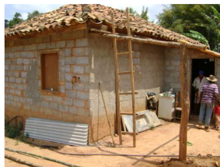
Figura 1 – Residência no bairro Nova Viçosa
