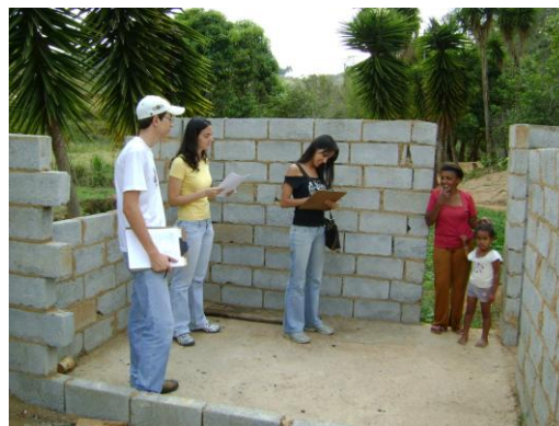
Figura 2 – Visita técnica no bairro Buieié
