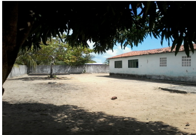
Figura 2 - Escola Municipal Marino Eleotério, situada em Zona Rural, Gramame, Conde, PB. Estrutura física básica da maioria das escolas construídas em zona rural no município do Conde, PB. Apresenta muros delimitadores de uma área grande em terra batida com poucas árvores e nenhuma horta.
