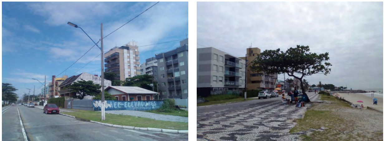
Figura 7. Aspecto dos trechos da Praia Brava, com edificações avaliados em R$ 420,00 o m 2 e R$ 280,00 o m 2 , respectivamente.
