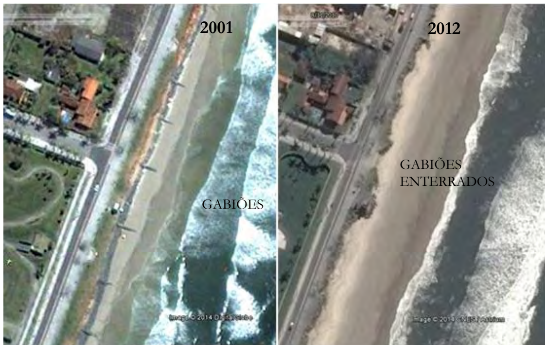
Figura 3. Comparação de trecho de praia. Observar os gabiões na primeira imagem, de 2001 e a falta dos mesmos em 2012, evidenciando o acúmulo de sedimentos neste trecho. Fonte: Intervenção da autora sobre imagens Google.
