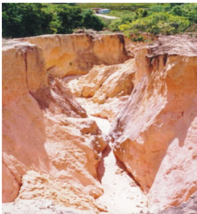
Foto 2 – Erosão presente no trecho, não representada na carta geográfica
