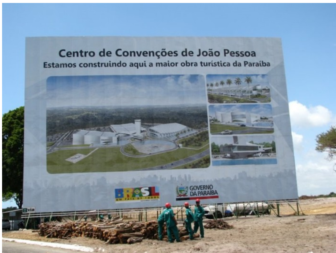
Figura 2 –Anúncio da obra do Centro de Convenções de João Pessoa, em construção na área do Polo Turístico Cabo Branco. A obra que estava planejada para ser concluída em dezembro de 2010, atualmente está parada.
