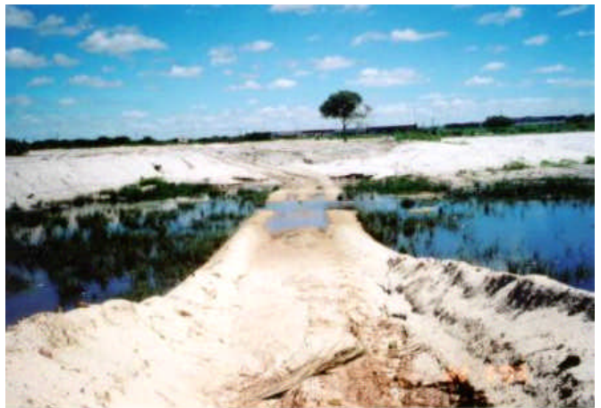
FOTO 3- Aterramento da zona de proteção ambiental (campos hidrófilos) da Fazenda Bela Vista, junho/2003. (Arquivo de Osvaldo C. Carvalho).
