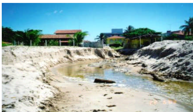
FOTO 2 - Lançamento das águas pluviais no antigo curso do maceió do Boto, hoje ocupado por residências do loteamento Jardim Areia Dourada, junho/2003 (arquivo de Osvaldo C. Carvalho ).
