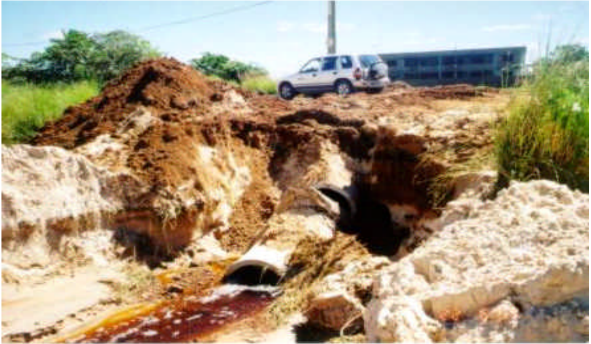
FOTO 4 - Vala aberta, emergencialmente, para escoar as águas pluviais acumuladas no loteamento Intermares e direcionadas ao maceió de Ponta de Campina (junho/2003). (Arquivo de Osvaldo C. Carvalho).
