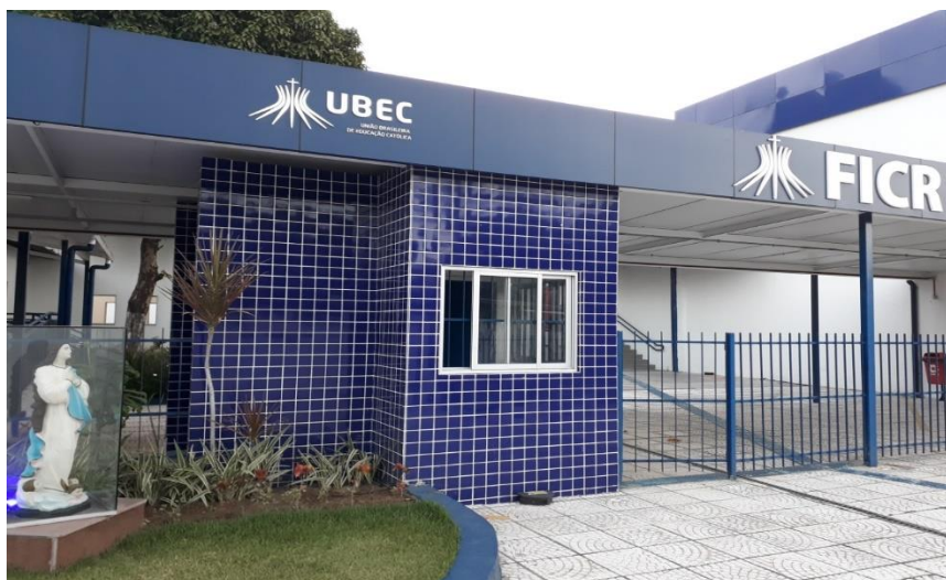
Figura 1 - Fachada lateral da Faculdade Imaculada Conceição do Recife
