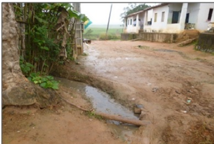
Figura 3 - esgoto a céu aberto (Sítio Jiboia).
