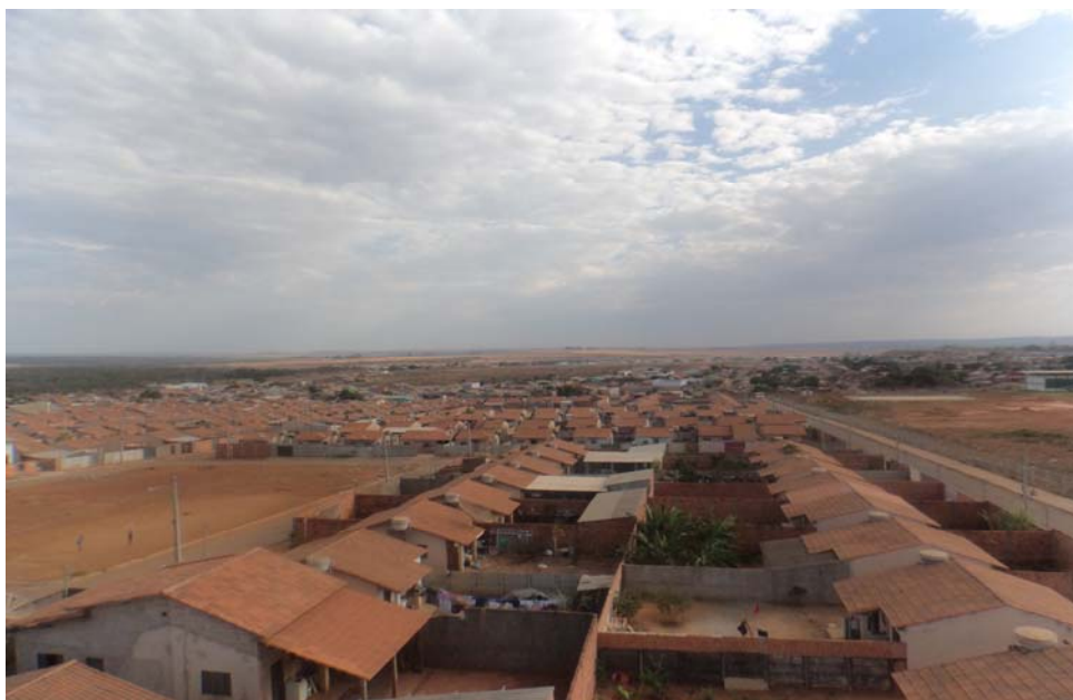
Figura 3. Localização do conjunto habitacional do Parque Lago no município de Formosa - GO.
