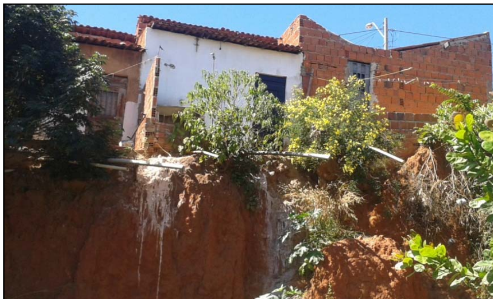
Figura 3: Padrão das edificações nas proximidades do talude de corte
