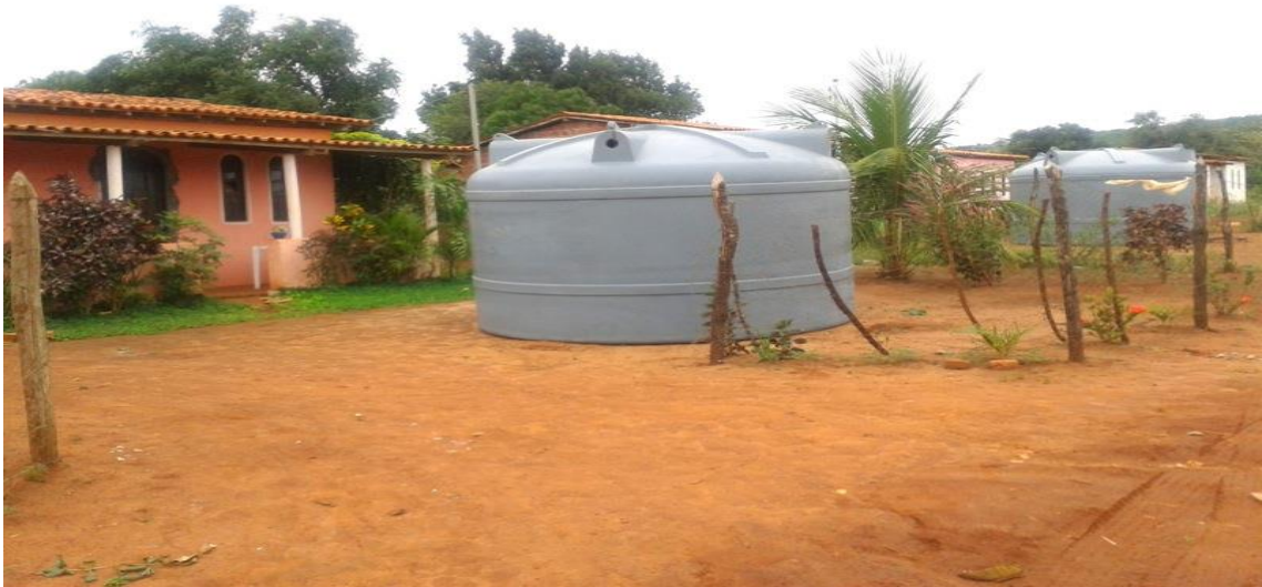
Imagem 02: cisternas de polietileno instaladas no perímetro rural.
