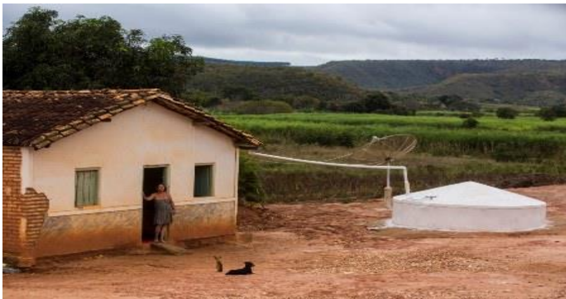
Imagem 01: cisterna de placa de cimento construída pelo P1MC.
