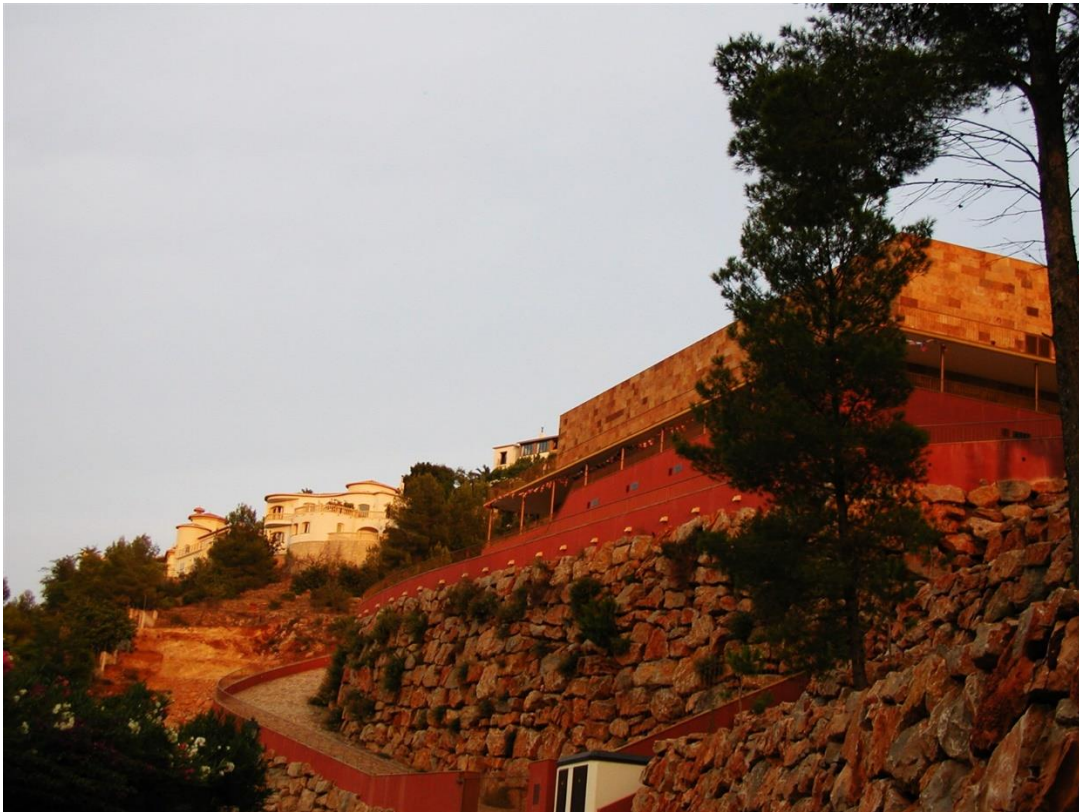
Ilustración 27: Vista del edificio desde la parte baja
