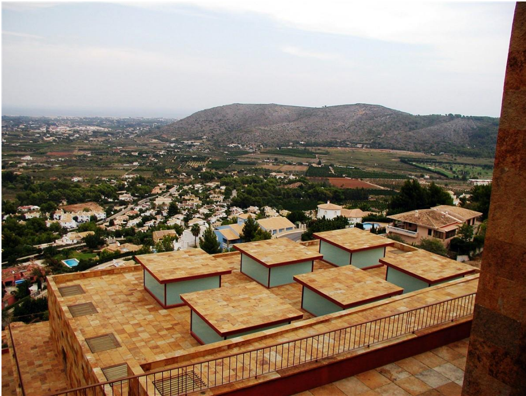
Ilustración 29: Tejado de la sala de meditación
