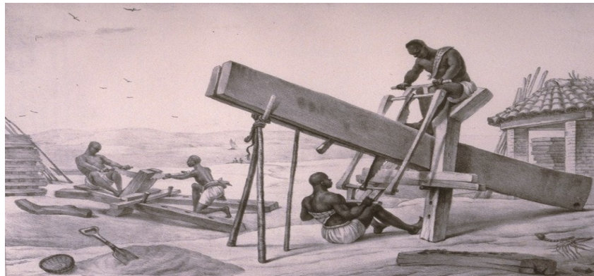
Figura 1: Serragens de tábuas de madeira (Debret) 4
