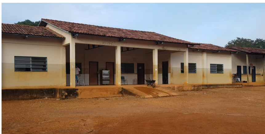
Figura 2: Fachada da Escola Wakômêkwa
