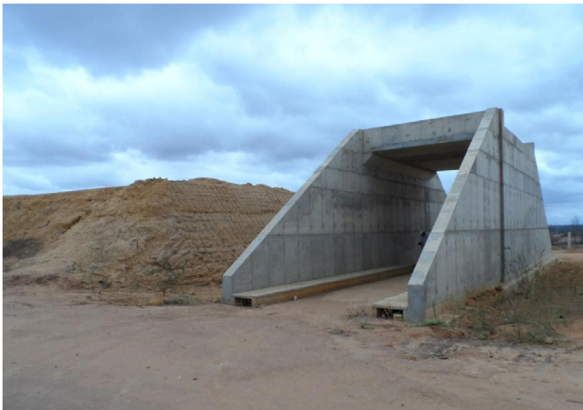
Imagem 13 - Trechos da construção da ferrovia entre às comunidades de Barro Vermelho e Contente – PI. Autoria: Laudirléa Silva dos Reis, 2014
