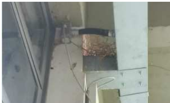
Fig. 01 – Ninho de pássaros em dutos de ar condicionado. Retirado de FERREIRA (2019). Disponível em http://hdl.handle.net/11449/183204
