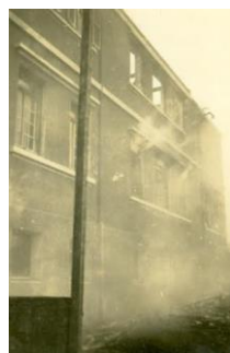
Figura 19: Parede frontal do prédio durante o sinistro
