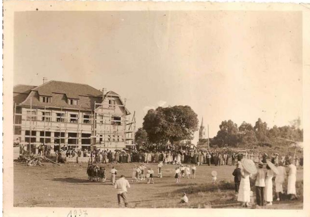
Figura 15 - Construção do Colégio Evangélico em 1937
