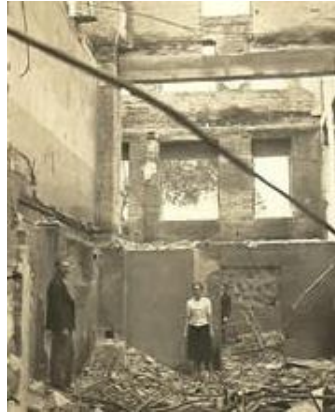
Figura 20 - Ruínas do Colégio Evangélico após o incêndio
