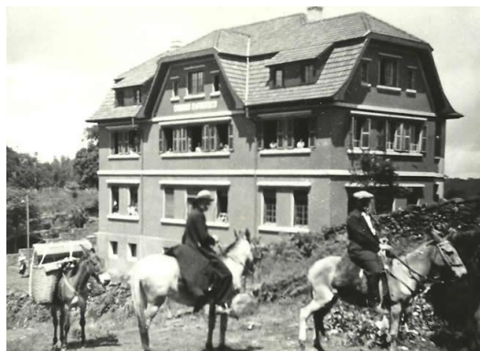
Figura 16 - Vista frontal e vista das mansardas do prédio
