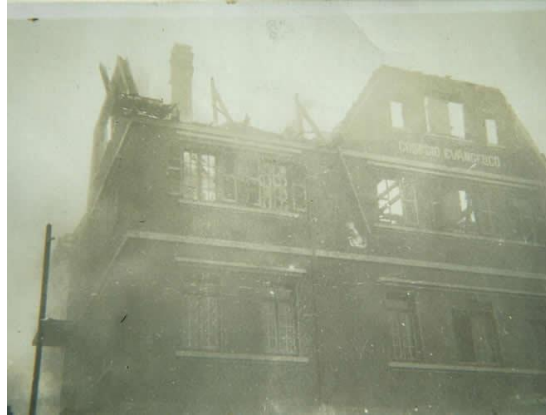
Figura 17 - Cenas do início do incêndio do prédio
