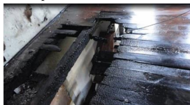
Figura 23 - Assoalho do 1º andar com visibilidade clara para as paredes do porão do prédio
