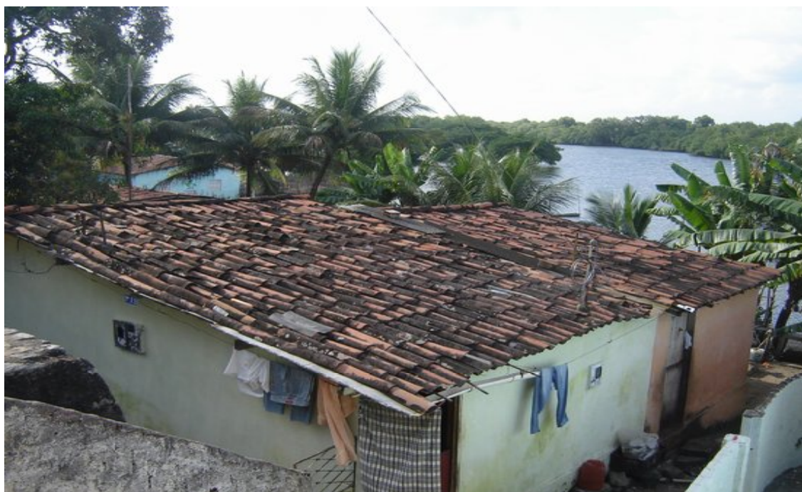
Figura: 02 . Casa construídas a margem do Rio Paraíba
