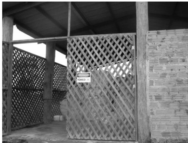
Figura 2. Local de armazenamento de agrotóxicos, Lagoa da Confusão – TO, 2009.
