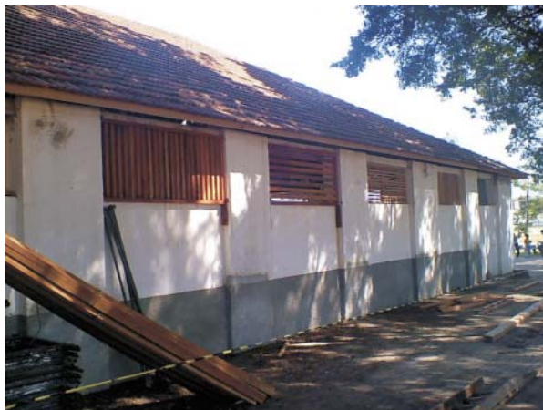
Figura 4 – Antigo salão de festas em restauro.
