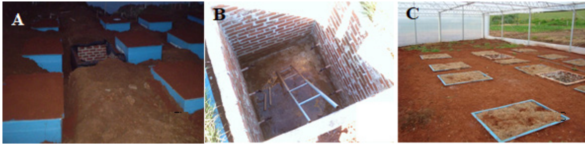
Figura 1. Vista parcial do conjunto de lisímetros de drenagem. A) Colocação do solo nos lisímetros, B) poço de observação e C) Vista final após os procedimentos de instalação.
